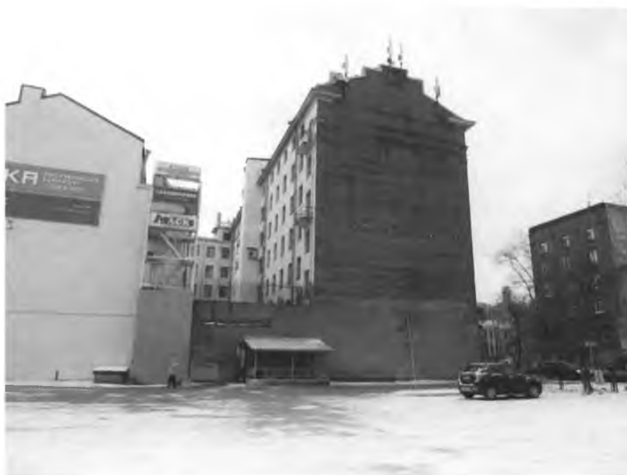
Фото 2. Торцевой северо-восточный фасад.
