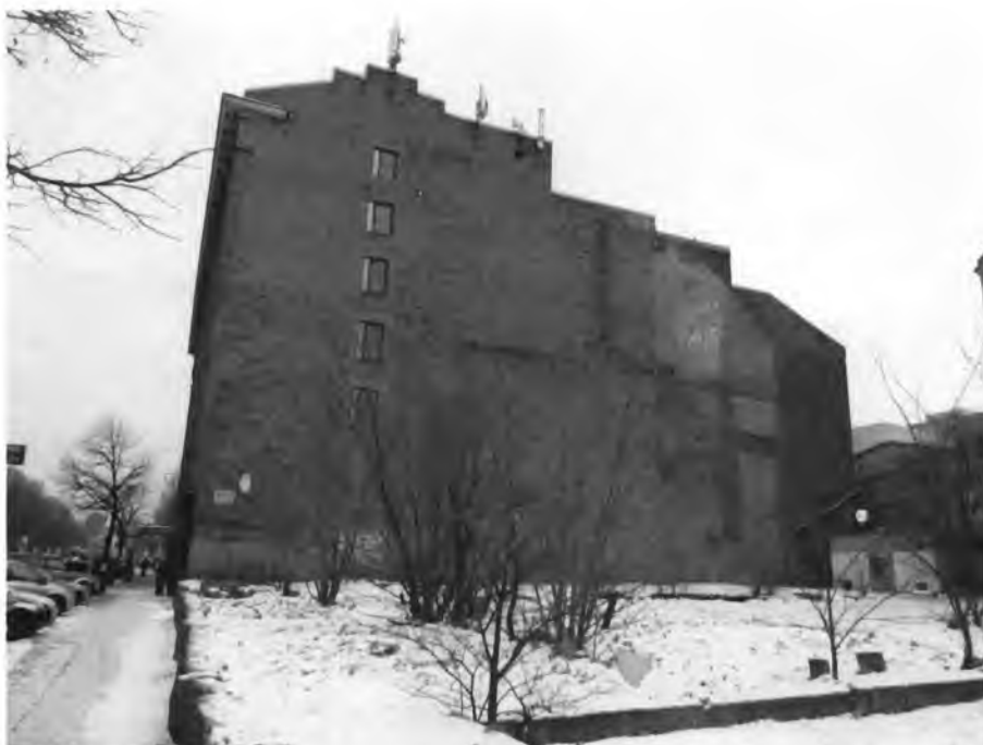
Фото 3. Торцевой юго-западный фасад.
