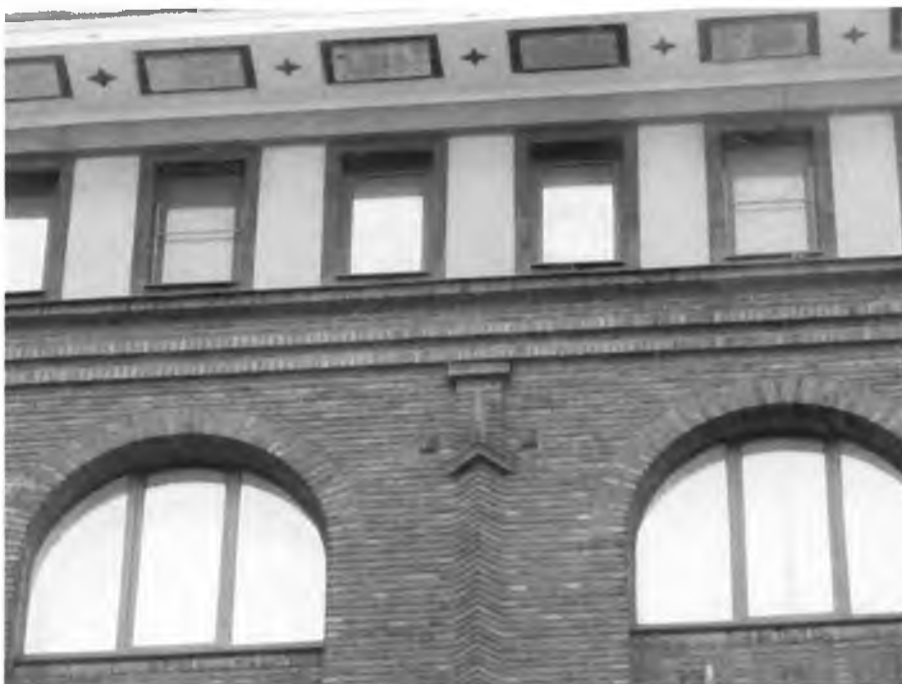
Фото 7. Детали главного фасада.
