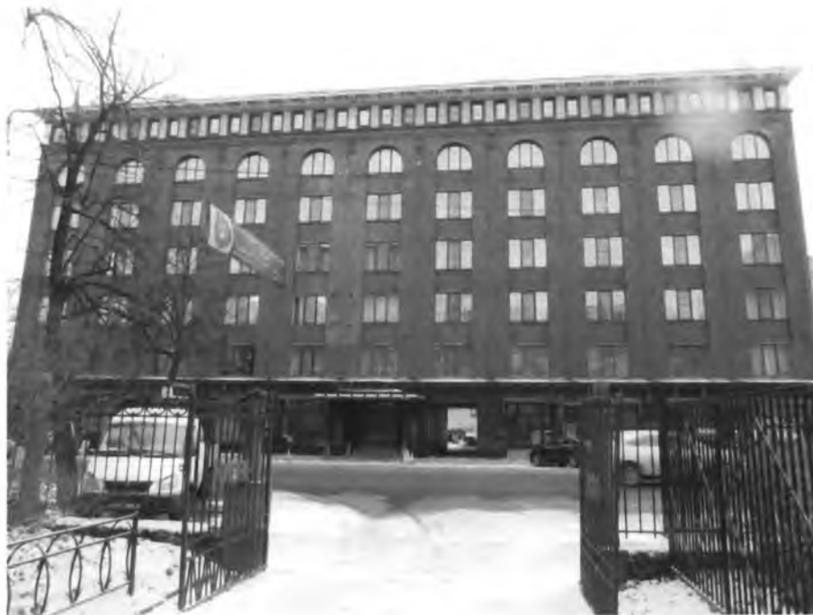
Фото 1. Главный фасад по Ленинградскому проспекту.
