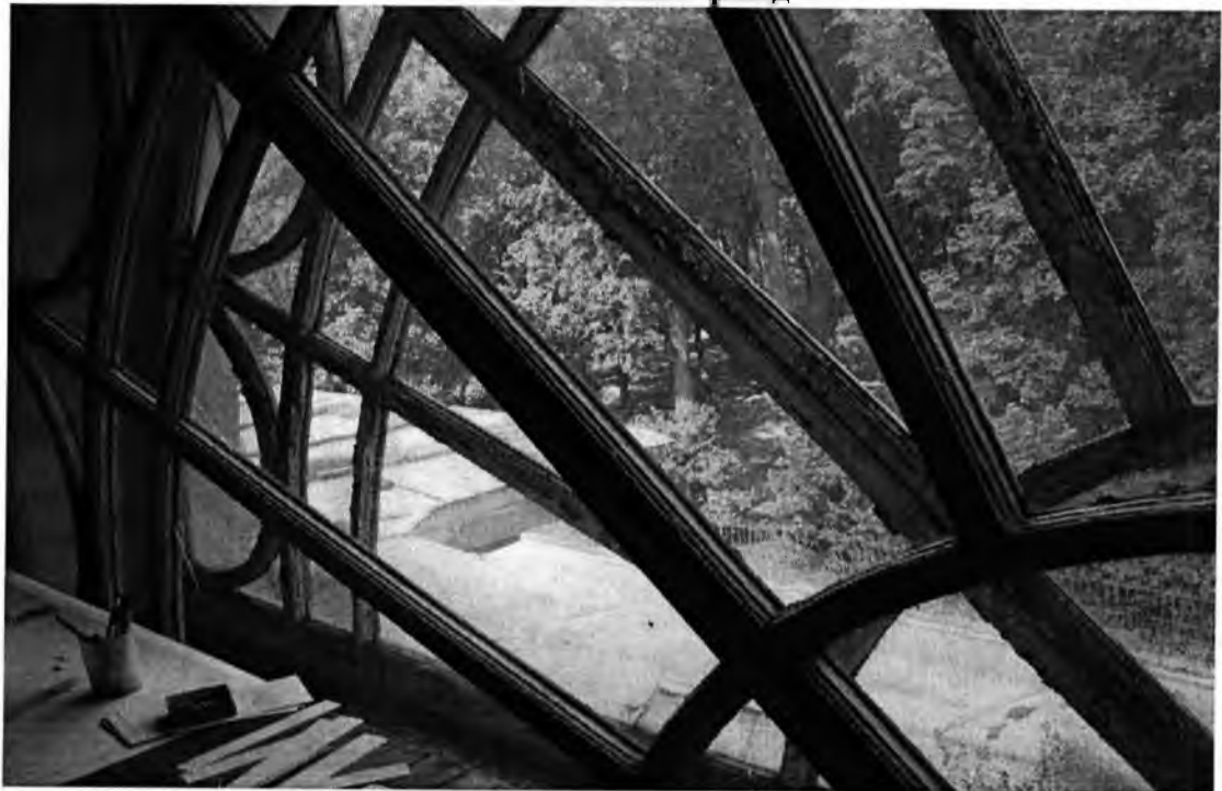
Фото 2. Фрагмент оконного заполнения
