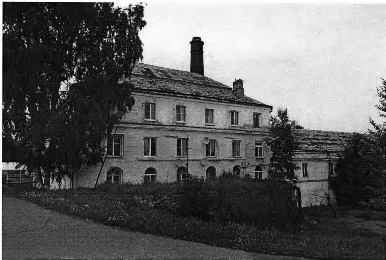
Фото 2 Юго-восточный фасад Дата съемки 29.07.2017
