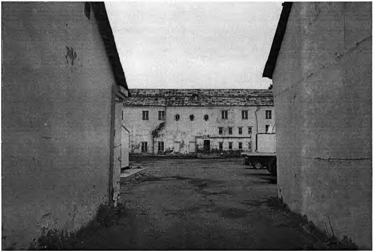
Фото 4 . Северо-восточный фасад. Вид во внутренний двор. Дата съемки: 29.07.2017
