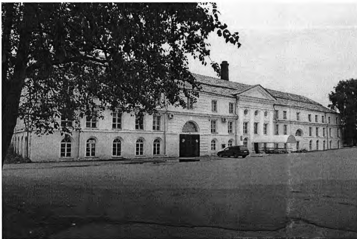
Фото 1. Юго-западный (главный) фасад. Дата съемки 29.07.2017
